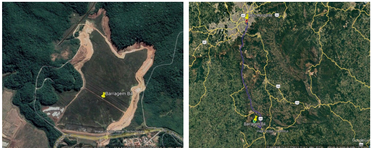
Figura 1 – Localização da Barragem B4. Fonte: Google Earth (27/07/2023).
